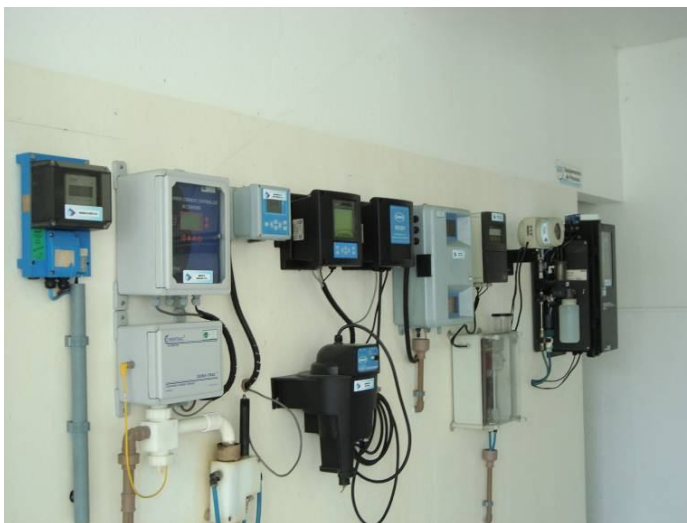
Figura 24: Equipamentos de medição flúor de turbidez com sinal 4 a 20 \mu A.
