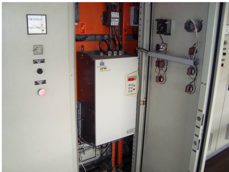
Figura 10: Painel elétrico com inversor de frequência de uma das bombas da captação de água bruta.
