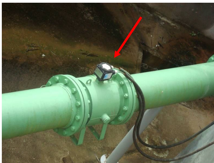
Figura 20: Macromedidor Eletromagnético do R4.
