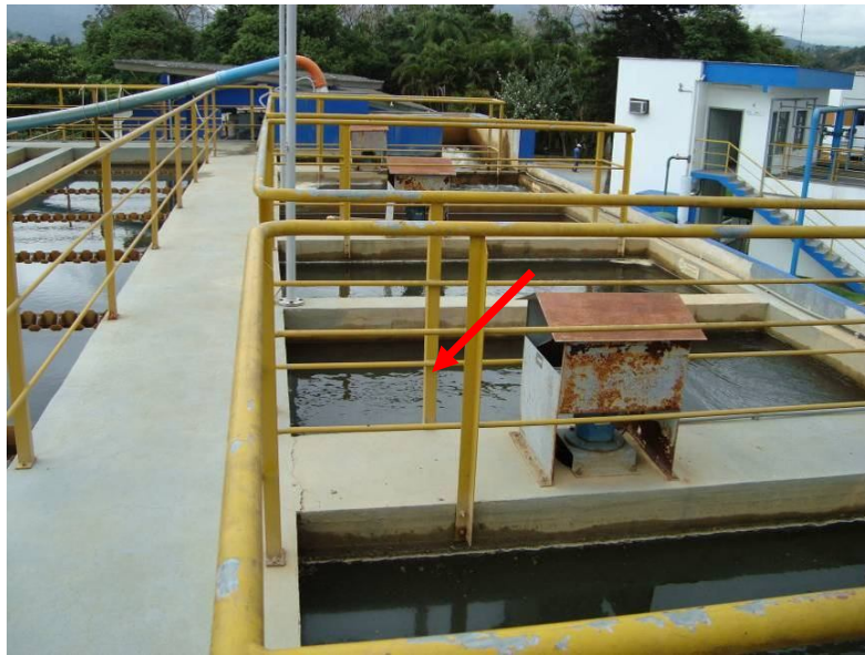
Figura 13: Floculadores mecânicos ETA II
