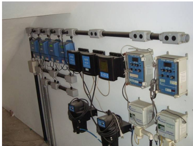
Figura 23: Equipamentos de medição de vazão pH e turbidez com sinal 4 a 20 \mu\text{A} .
