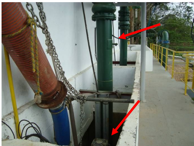
Figura 9: Poço de sucção com adutora de água bruta
