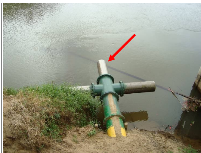
Figura 8: Cripina em forma de Tê localizada na margem do Rio Itapocú.
