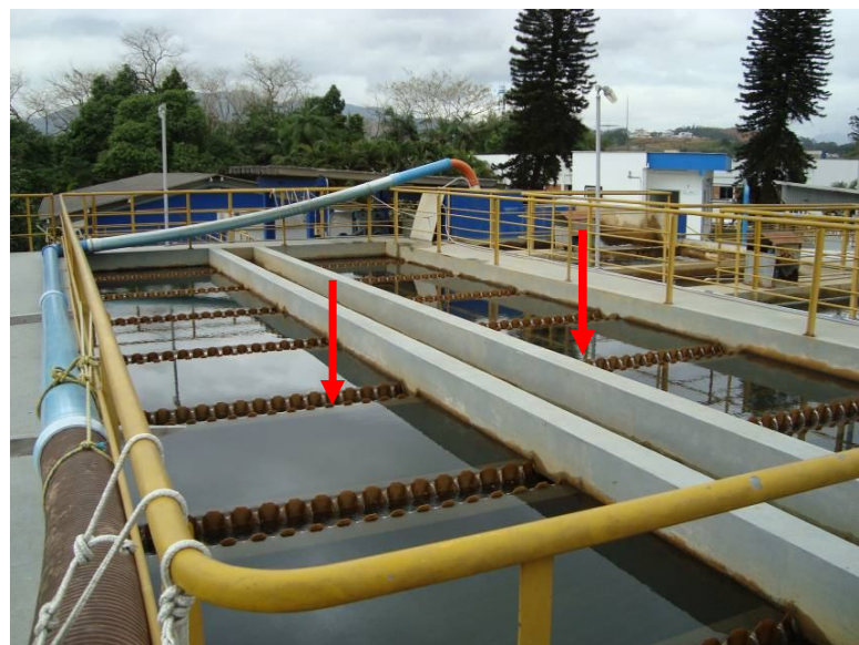
Figura 14: Decantador do tipo alta taxa ETA II.
